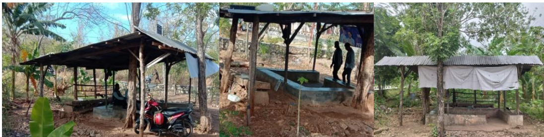
Gambar 2. Kondisi eksisting Bangunan Pangkalan Ojek
