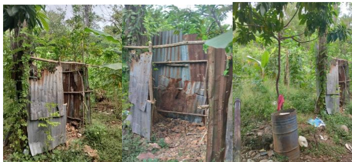
Gambar 3. Kondisi WC darurat
